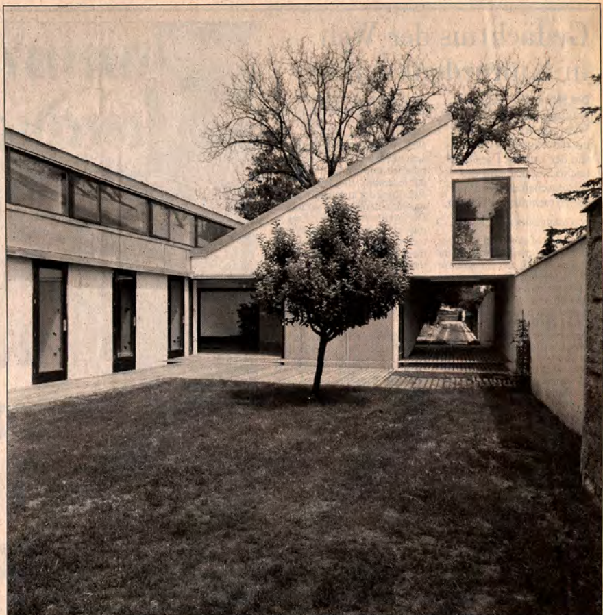
Collage aus unterschiedlichen Baukörpern: Einfamilienhaus Spuller in Wien-Kagran von ARTEC. Photos: Paul Giuliani
